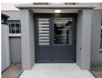
Drzwi wejściowe do Wydziału Legalizacji
